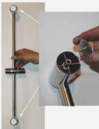
Placera limbelagda brickorna i skruvhålen.
