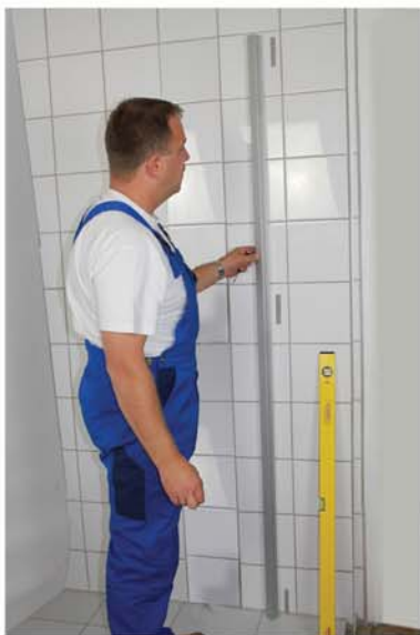
Lösgör muttrarna och tag åter loss profilen från väggen. Montagebrickorna sitter kvar på väggen.
