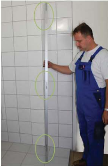
Fäst 3st montagebrickor per profil
